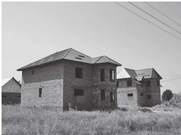
写真4. ノヴァパクロフカの建設中の家屋(2017年、筆者撮影)
